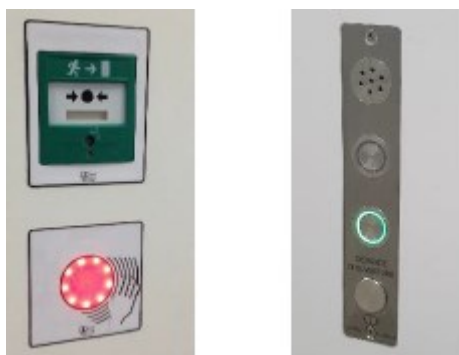
Figure 4 | Exemple Platine interlockage + DM vert
